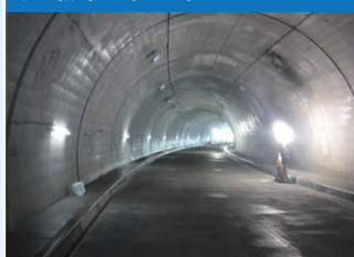
逢瀬第1トンネル
