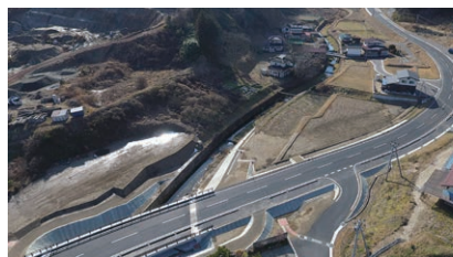
県民待望の完成を迎えた国道114号山木屋工区④と国道349号大綱木工区
